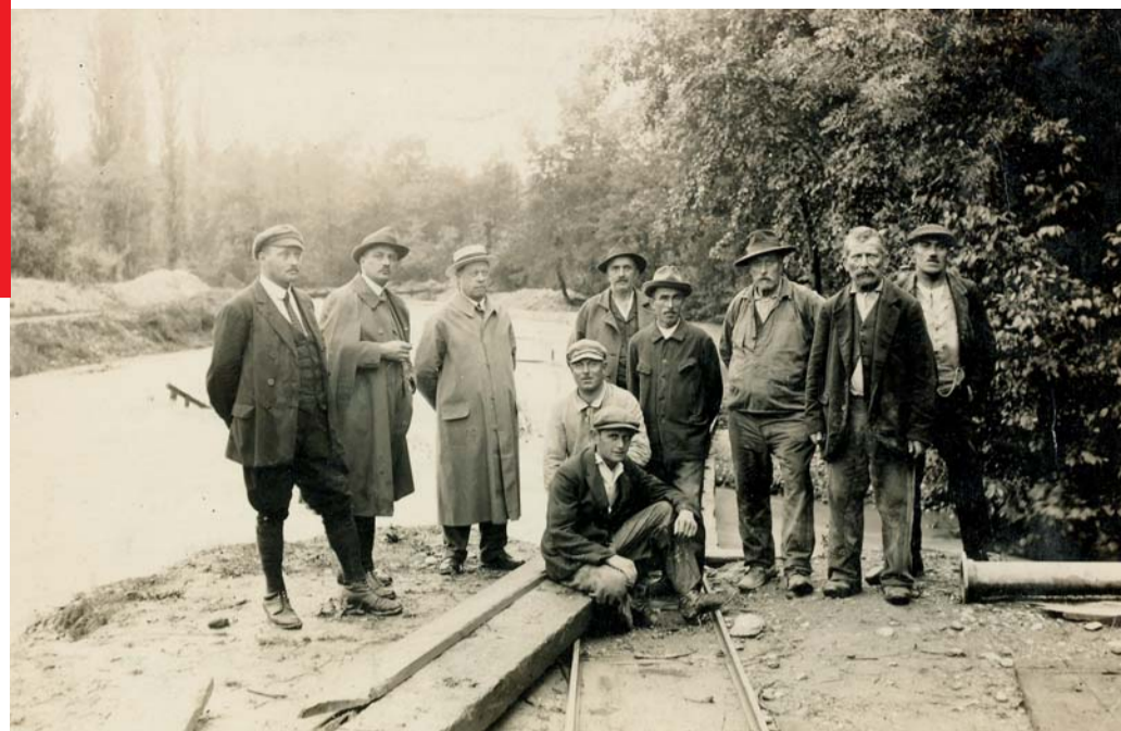
OUVRIERS TRAVAILLANT AU CANAL DE L'AIRE. BGE-CIG
