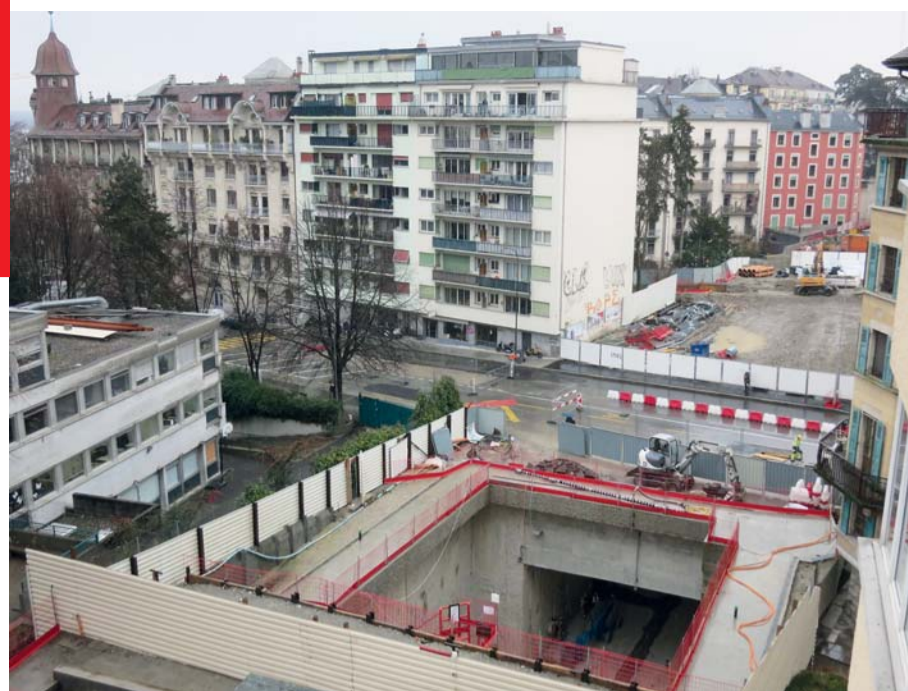
LES TRAVAUX DE CEVA SOUS L'AVENUE WEBER EN 2014.
