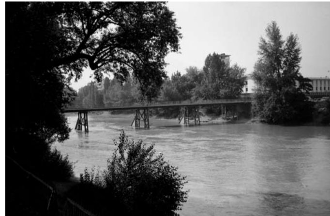
L'ANCIENNE PASSERELLE DES VERNETS, CONSTRUITE EN 1958. BGE-CIG
