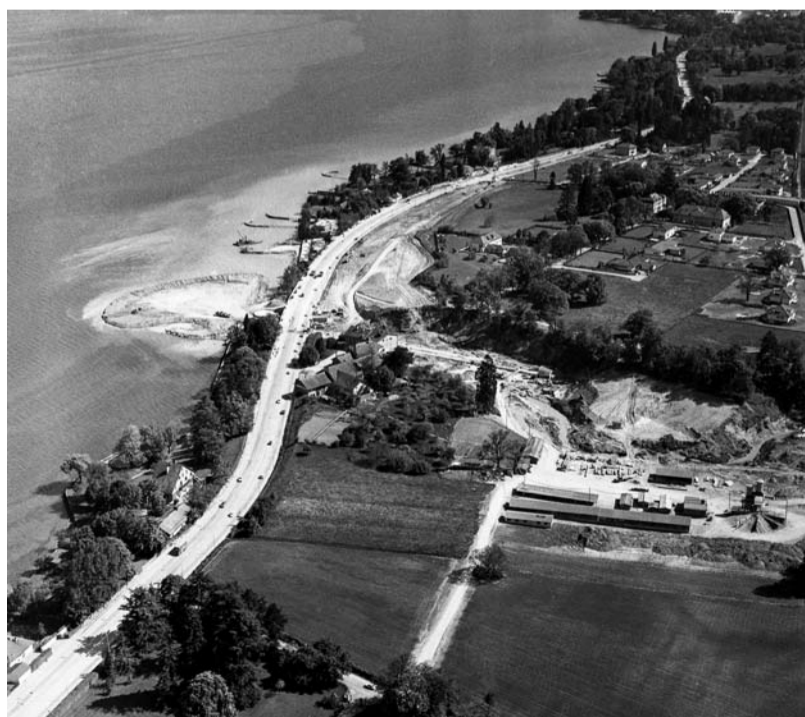
AUTOROUTE GENÈVE-LAUSANNE, CONSTRUCTION DE L'ÉCHANGEUR DU VENGERON. KEYSTONE
