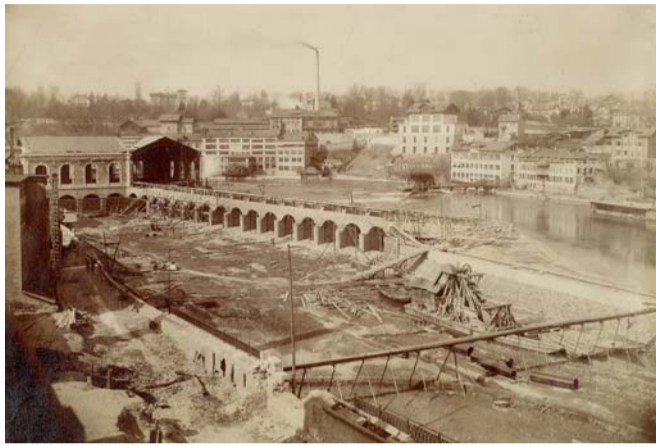
LE BÂTIMENT DES FORCES MOTRICES EN CONSTRUCTION, ENTRE 1883 ET 1886. BGE-CIG
