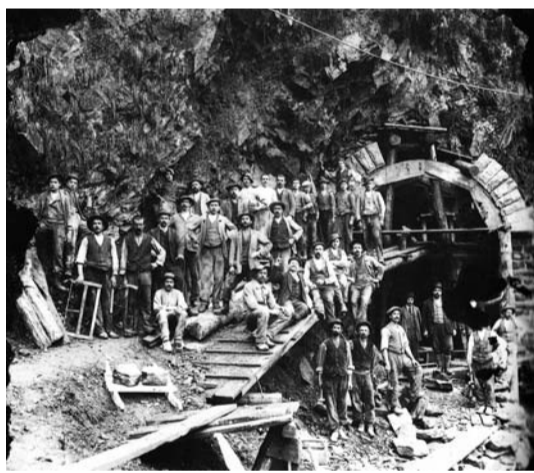
UN GROUPE D'OUVRIERS DEVANT LE TUNNEL DU SIMPLON, 1899.
