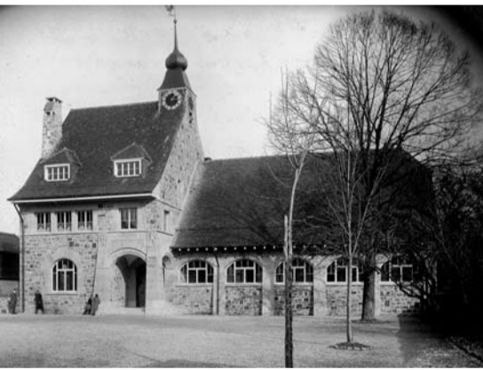
LA MAIRIE-ÉCOLE D'ONEX, CONSTRUITE EN 1908-1909. BGE-CIG
