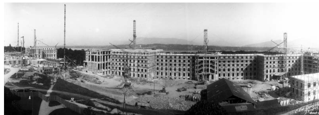
CHANTIER DU PALAIS DES NATIONS, AOÛT 1932. BGE-CIG
